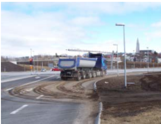
Mikil mold getur borist með vörubílsdekkjum frá framkvæmdasvæðum.
